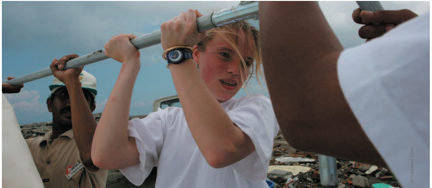
➤ Banda Aceh, construction d'un poste de santé.
